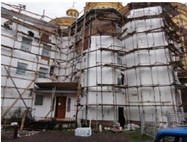
Neue Gebäudeisolation beim Wolodymyr
